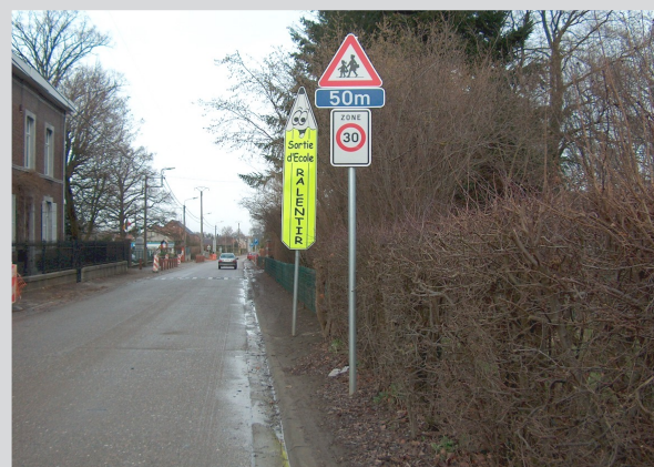
Pose de panneaux de signalisation acquis dans le cadre du plan ZEN
