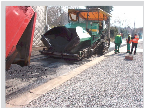
Pose tarmac rue E. Vandervelde à Borlez
