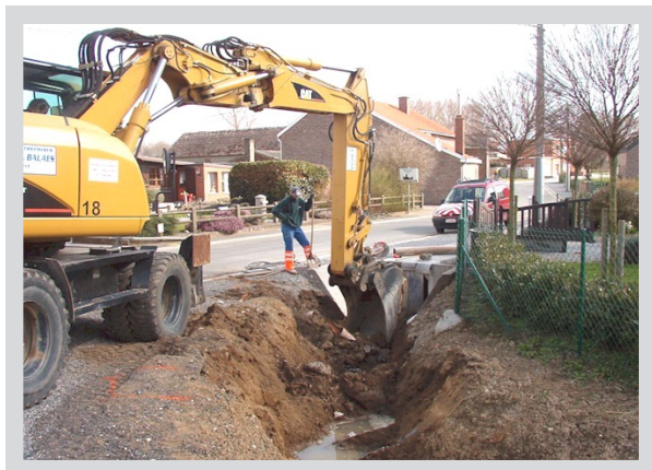
Pose canalisations rue du Moulin à Viemme
