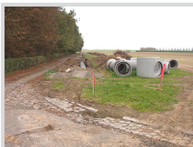
Chantier Remembrement: Bosquet.
