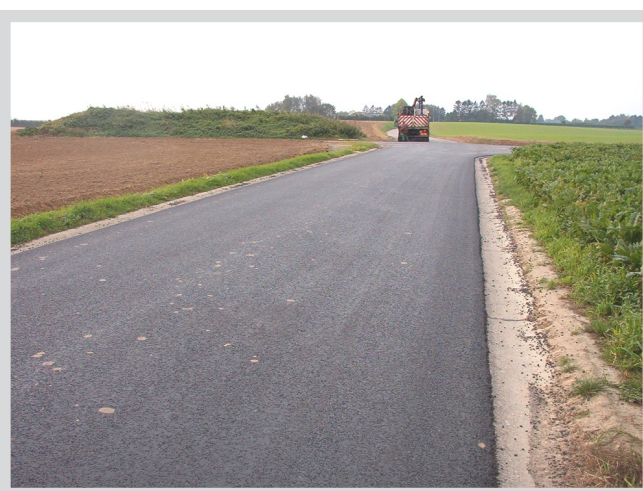
Nouveau revêtement rue A. Jamoulle vers Bovenistier.
