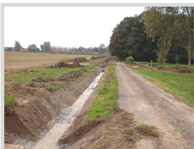
Chantier Remembrement: Fossé chemin d'Omal.
