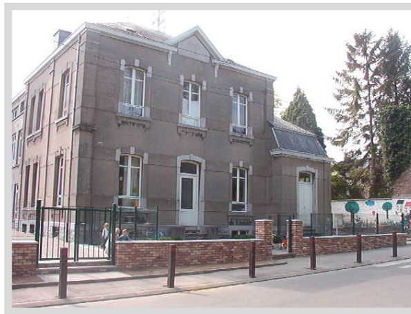
Construction d'un nouveau mur devant l'école communale de Les Waleffes
