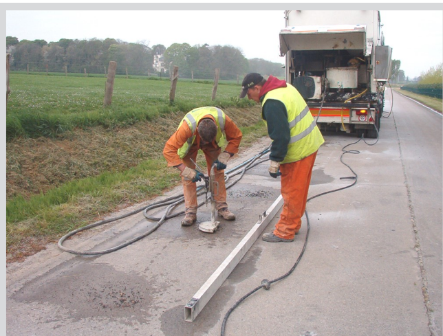
Relèvement des dalles en béton chemin d'Omal à Les Waleffes grâce à l'utilisation d'une technique toute particulière qui consiste à injecter du béton sous la dalle afin de la relever.
